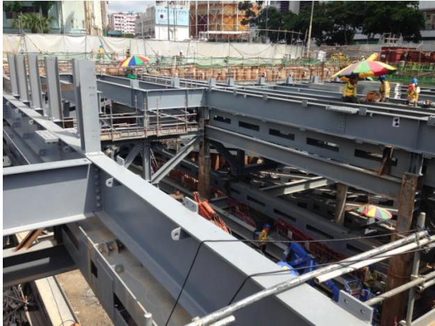
Fig.2 ELS works of the access shaft in Ma Tau Kok site
